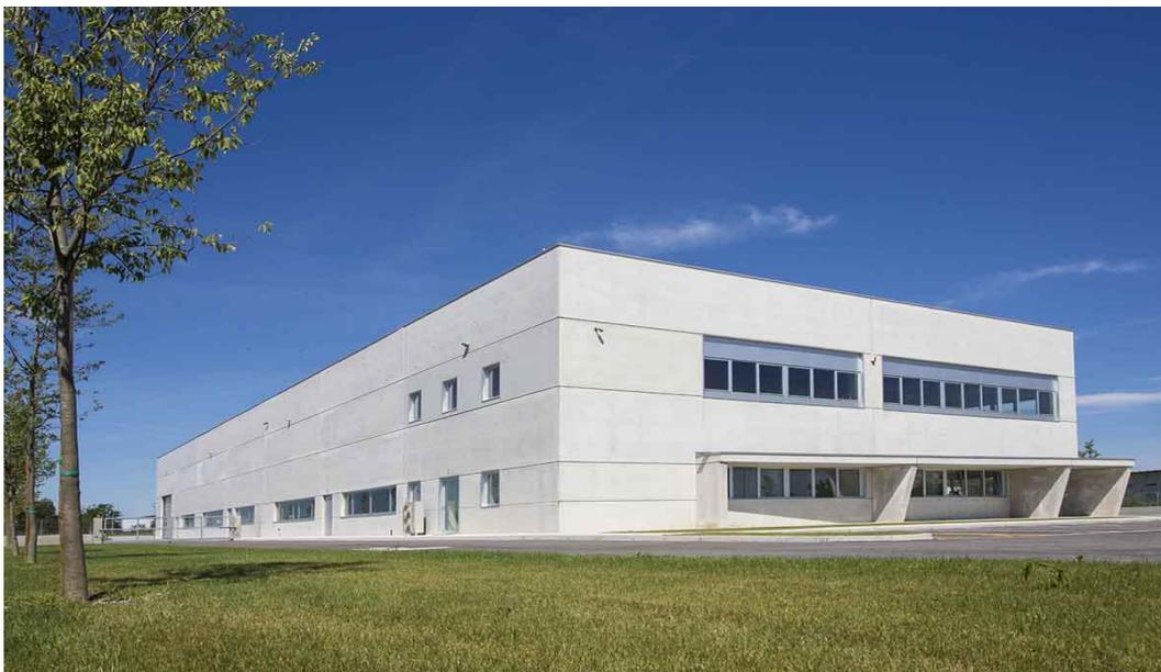
Capannone industriale edificato nel 2016 avente struttura prefabbricata ad un piano con copertura piana.
