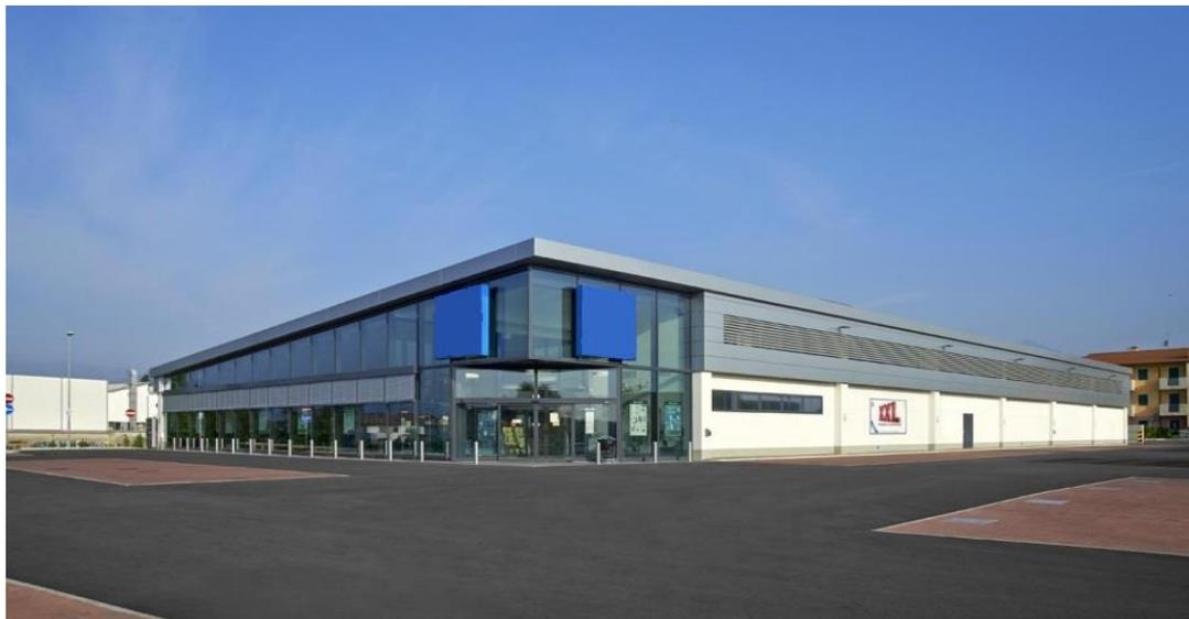
Edificio destinazione commerciale (grande magazzino) edificato nel 2010 avente struttura prefabbricata pesante ad un piano con copertura piana.
