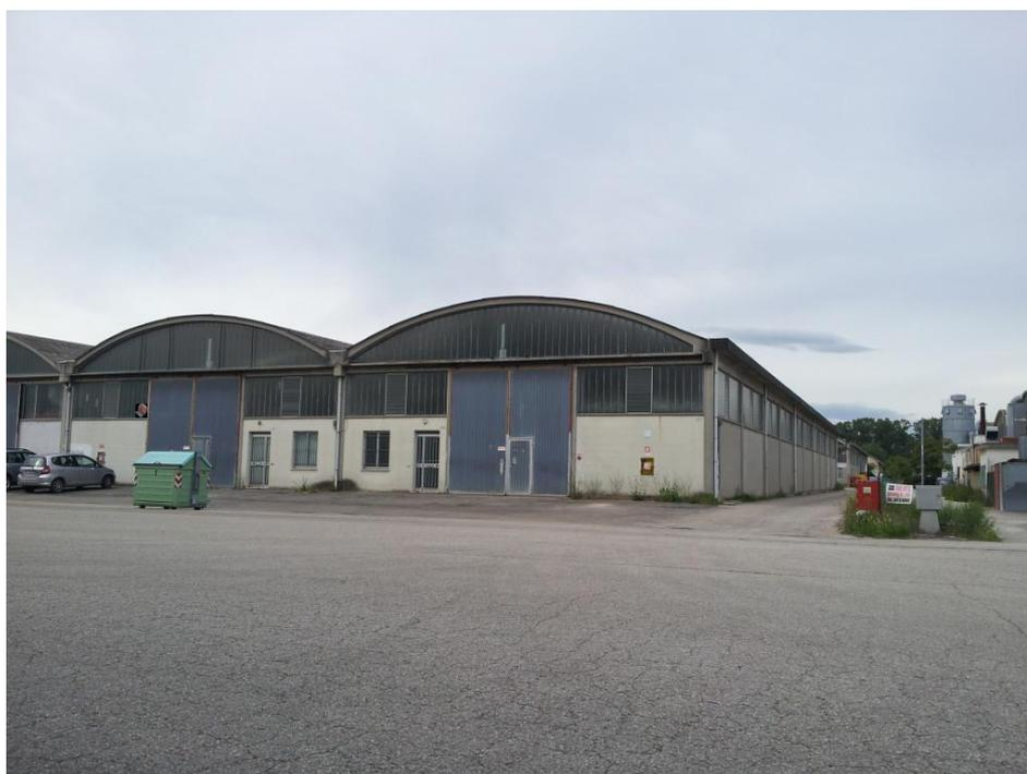
Capannone industriale edificato nel 1980 avente struttura in c.a. ad un piano con copertura a volta e presenza di tiranti interni che ne limitano l'utilizzo.
